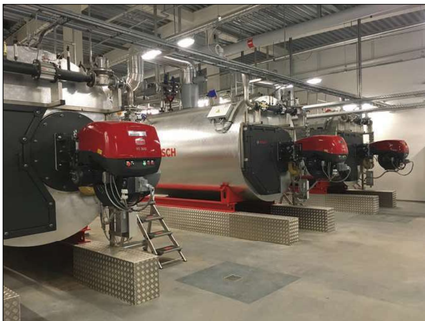
I normal driftstilstand er der reelt kun behov for en dampkedel - de to resterende er backup.
